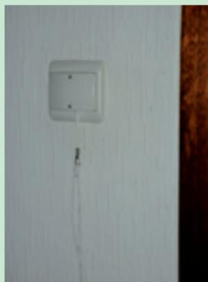
Un commutateur à tirage ou aussi appelé «type tête de lit» avec une balle de tennis permet à la personne d'actionner le contact sans réaliser de mouvement traumatisant pour son épaule
